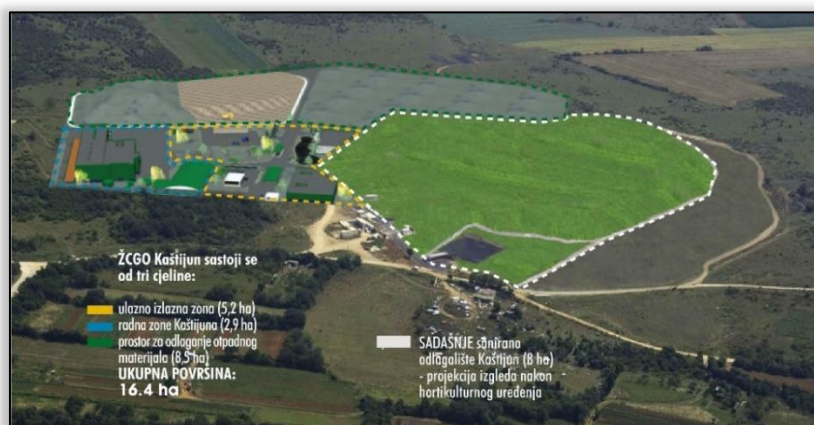
Slika 11. Zona za odlaganje otpada ŽCGO Kaštijun
